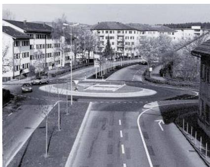
Dopo aver trasformato l'incrocio in una rotonda, gli incidenti si sono diradati e la formazione di colonne è sensibilmente diminuita. Grazie al risparmio derivato dal calo degli incidenti, i lavori di trasformazione hanno potuto essere ammortizzati in breve tempo.
